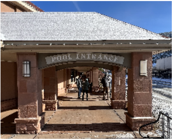
4 Existing Condition - Scale: N.T.S.
