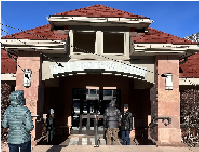
4 Existing Condition - Scale: N.T.S.
